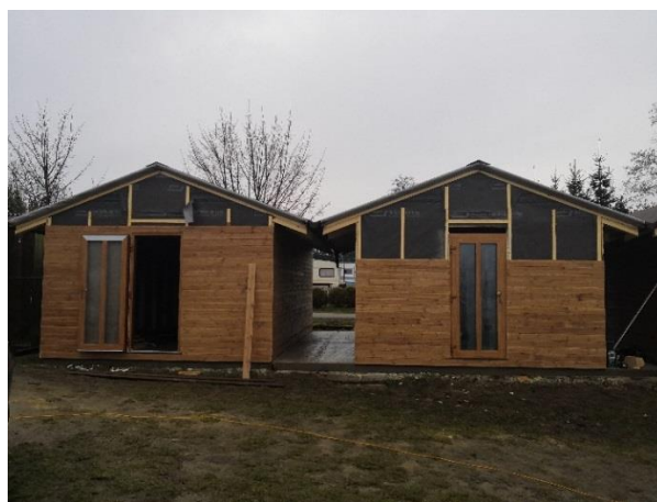
dokončovací práce na zevnějšku
