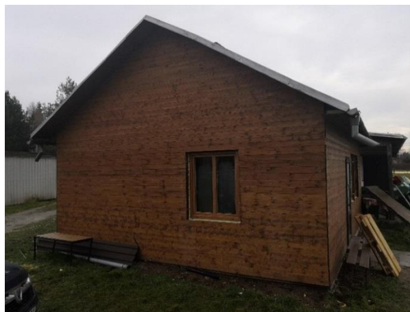
nově opláštěná loděnice
