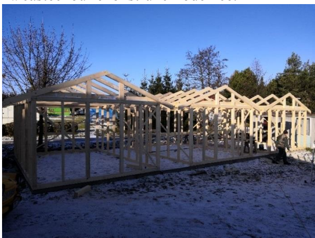
výstavba nových chatek
