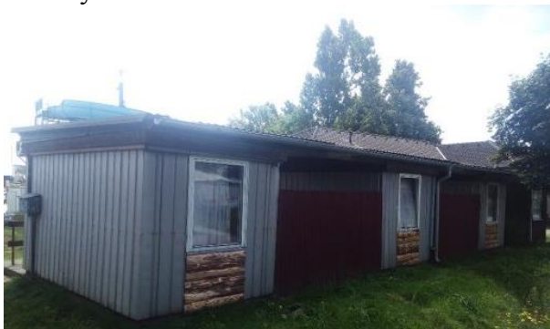
původní unimobuňky sloužící k ubytování
